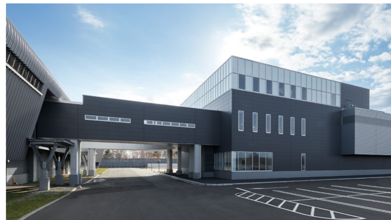
石狩データセンター 3号棟
